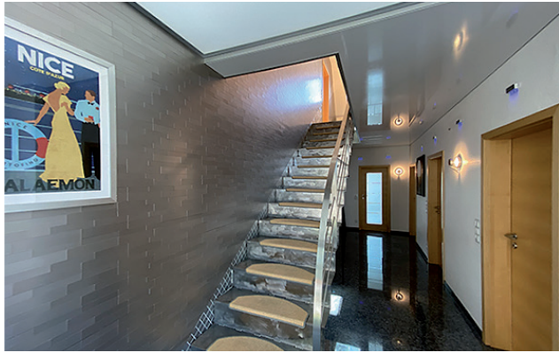
Stahlterppte, Wandglasfliesen, Blue Pearl, Marmorboden im Flur EG
