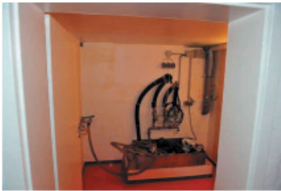
Kellerräume mit neuer Heizungsanlage, Boden kunststoffbeschichtet
